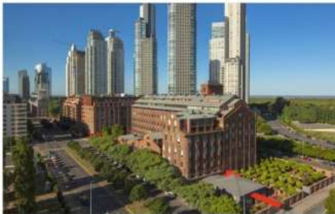
Figura 2 – Faena Hotel, em Puerto Madero
