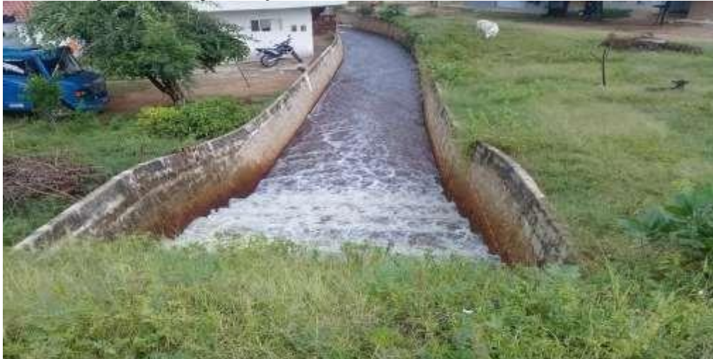
Figura 05 – Sangria do açude do Bairro Vida Nova, Pombal-PB, durante fortes chuvas.
