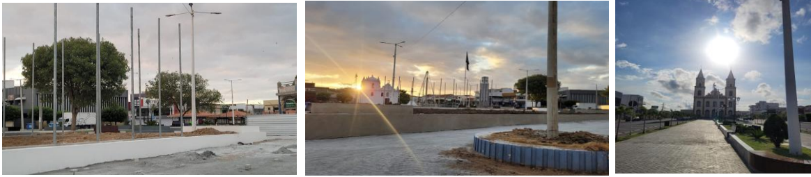
Figura 5 – Paisagem em Ruínas e Comprovada Perda do Sombreamento
