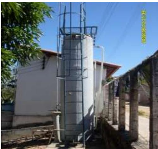
Figura 1: Vista de frente do reator UASB
